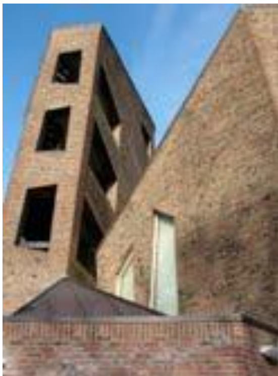
de toren en het dak van de aanbouw
